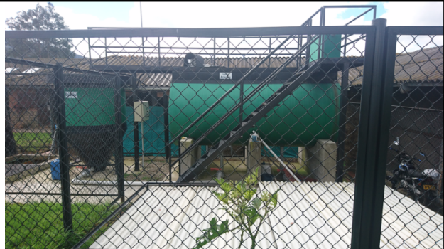
Foto No. 2. PTAR
